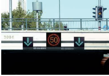
Resim 3.10. Azami hız ve şeritlerle ilgili VTS'lerden oluşan örnek bir sistem [12]
