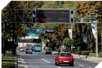
Resim 3.12. Köprü trafik yoğunluğunu gösteren bir VMS [11]
