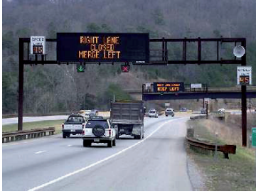
Resim 3.8. VMS ve şerit yönetimine ilişkin VTS'lerden oluşan örnek bir sistem [10]
